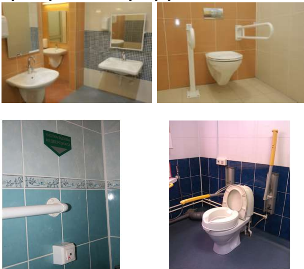
Примеры оборудования санитарно-гигиенических помещений 41
